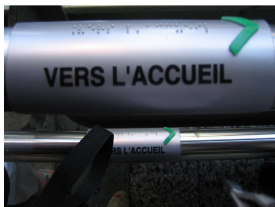
Illustration 11: Inscription en braille sur une rampe d'escalier à la gare Montparnasse
